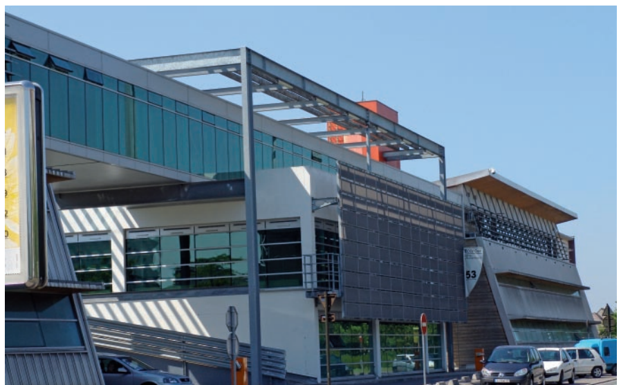
Ecopolis, hôtel d'entreprises, Amiens Nord
